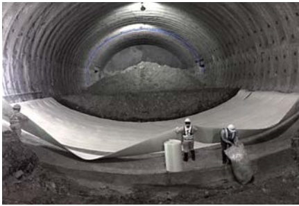
① 養生マット敷設
