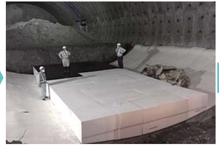
③ 保護シート敷設
