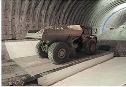
⑤ 設置完了
