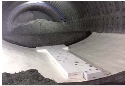
② エスレンブロック設置
